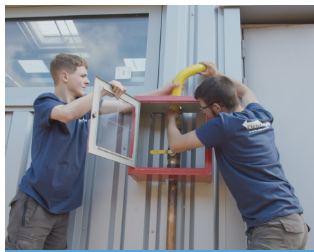
| Installation d'un réseau gaz dans une usine (250 m de DN 50 – Branchement 18 aérothermes DN 25)
