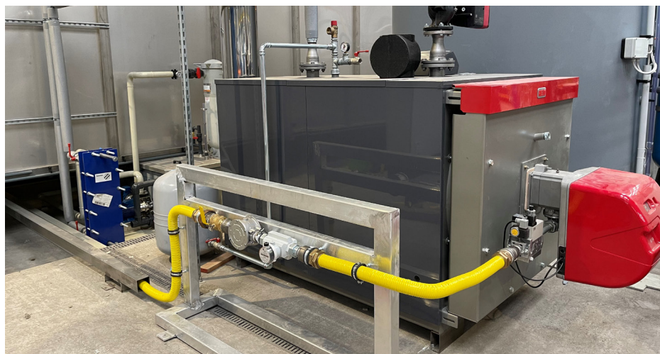
Installation d'un réseau gaz pour raccordement de 3 brûleurs gaz de 450 Kw alimentant une ligne de peinture chez un fabricant de portails (DN 40 / DN 20)
