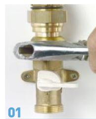
01 Monter le raccord FLEXICLIC sur le robinet
