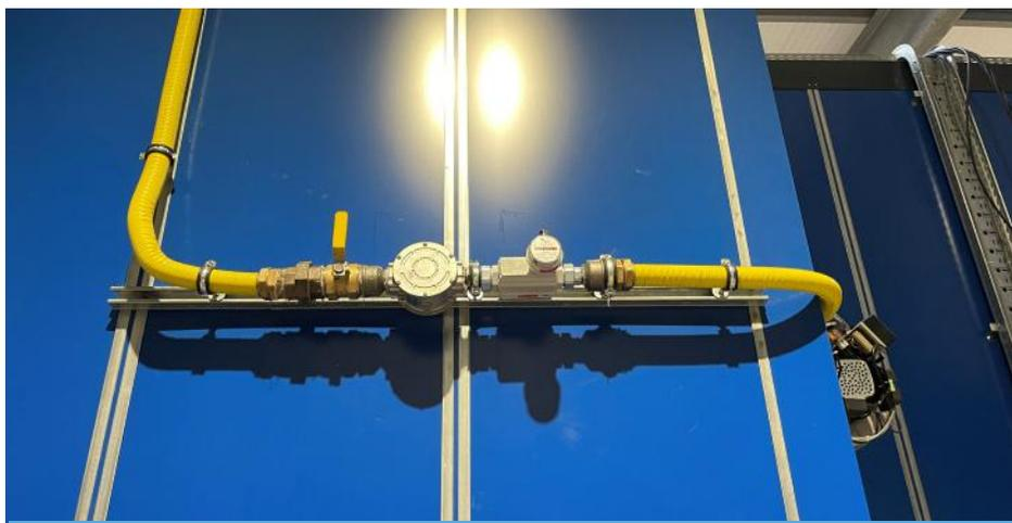
Installation d'un réseau gaz dans une jardinerie avec branchement aréotherme (DN 32).
