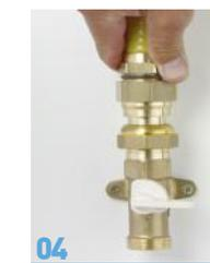
04 Serrer l'écrou pour bloquer le tuyau FLEXIPIPE
